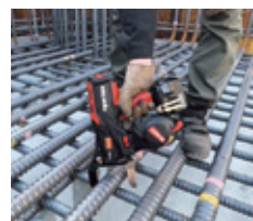
土木工事 橋梁 フーチング D51×D32
