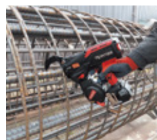
場所打ち杭 鉄筋かご 3層組 D32×D32×D13
