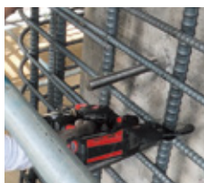
土木工事 橋梁 補強工事 D38×D22
